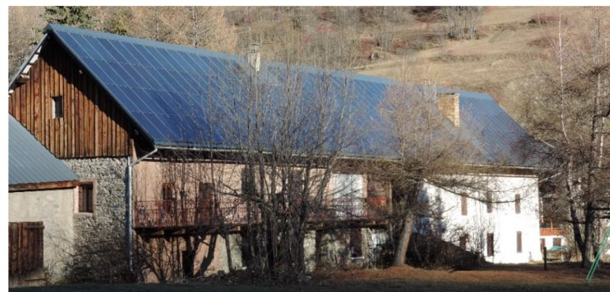
*Réhabilitation de toiture par panneau solaire. Garde de corps en ferronnerie à barreaudages verticaux.*
