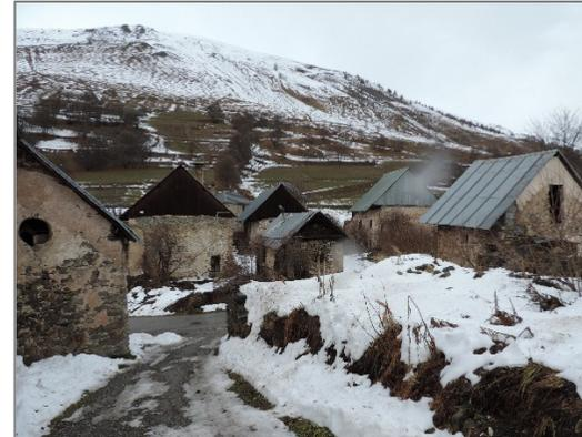
*Façade en pierres, combles en bois, toitures à 2 pans en tôle.*
